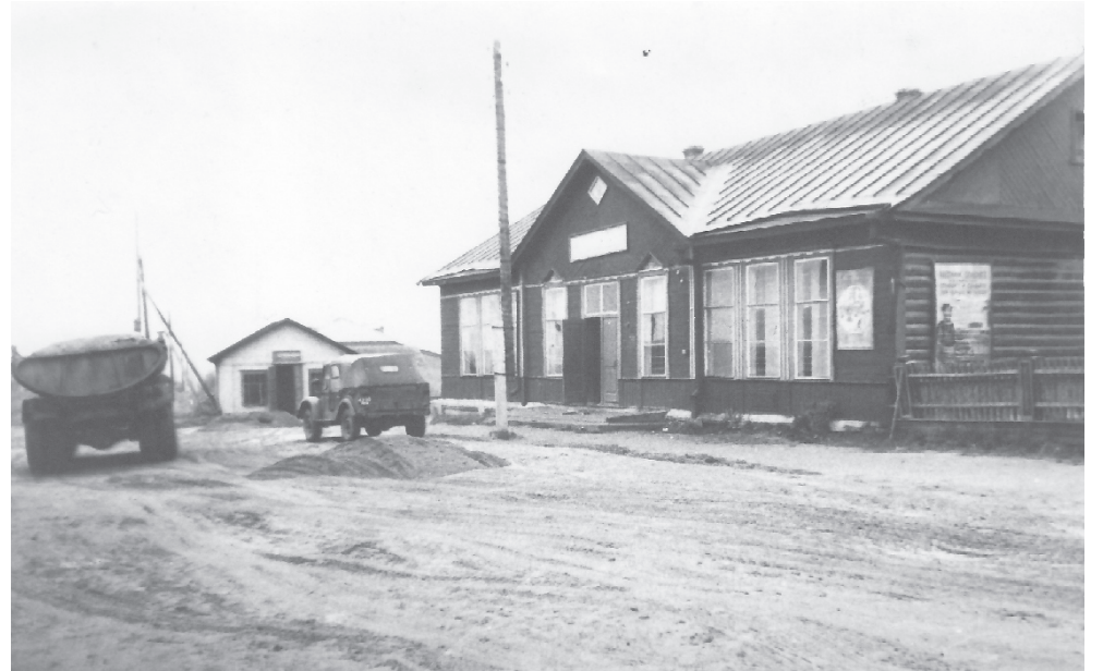
На фото: строительство дороги в центре поселка
