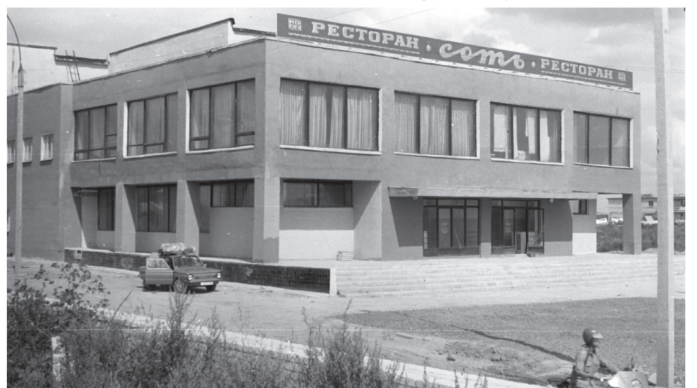
На фото: здание ресторана Сеть 1980-е годы
