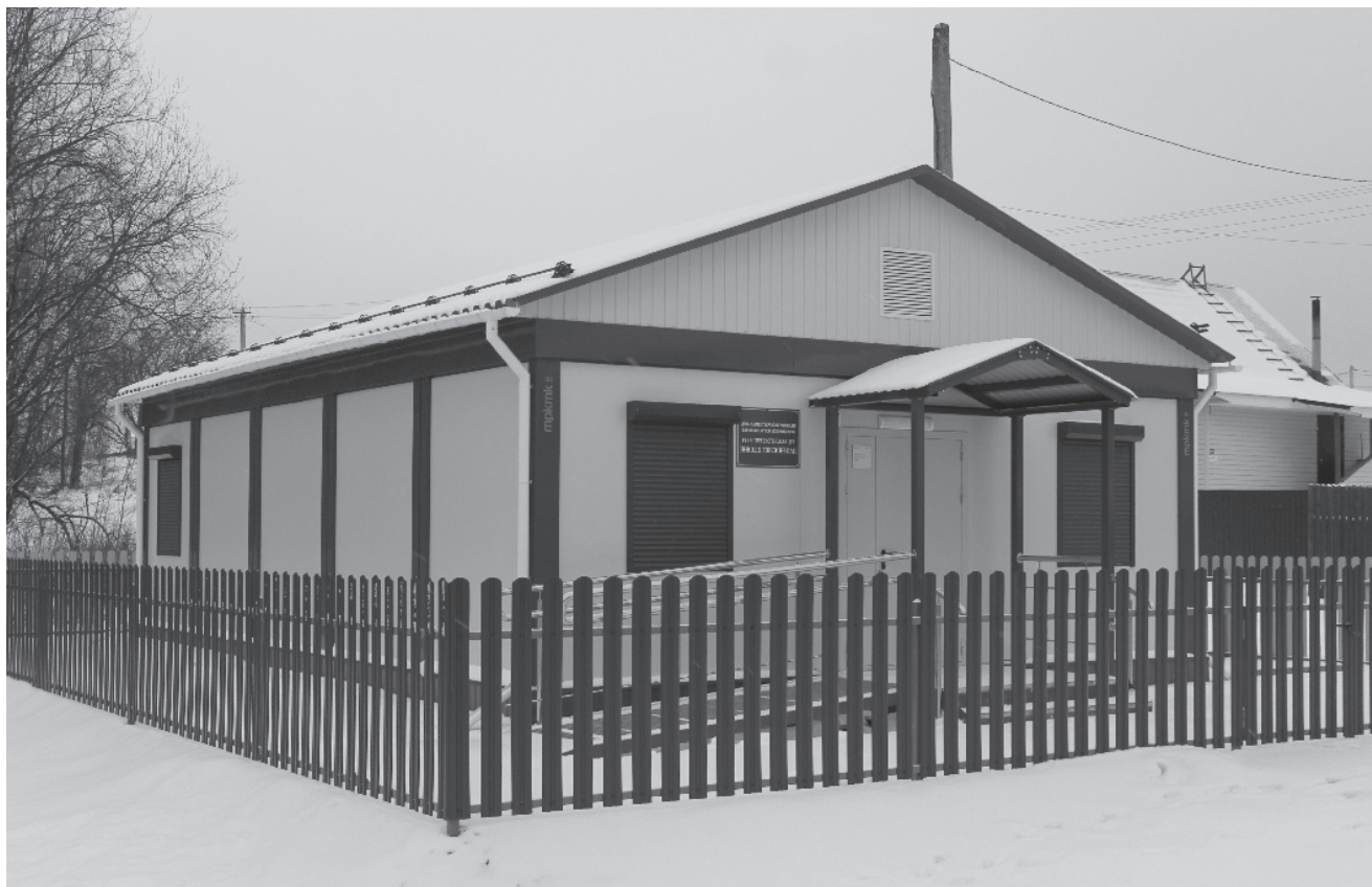
На фото: новое здание ФАПа в с. Николо-Гора
